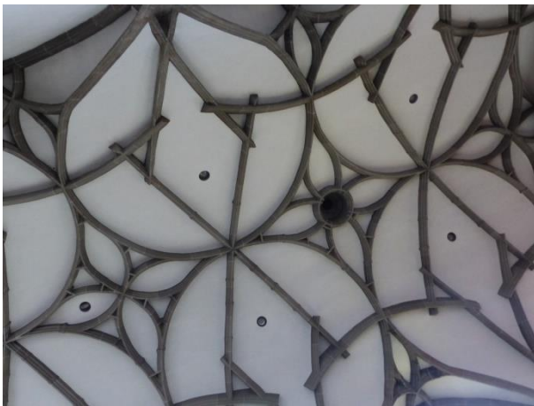
Gewölbe Pfarrkirche Haslach
